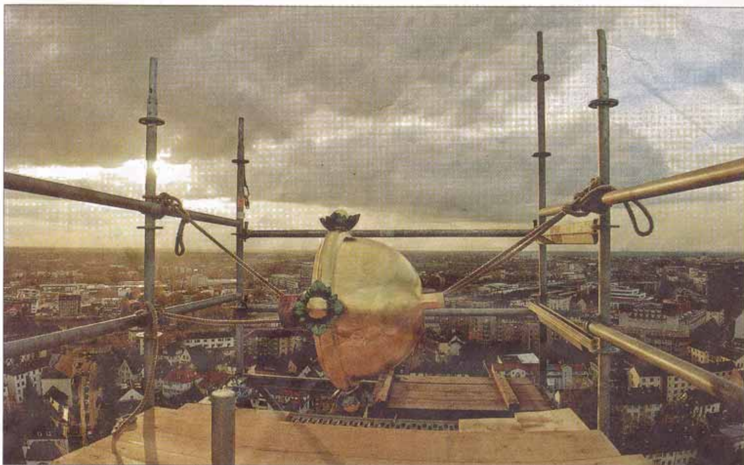
60 Meter über Heidelberg wartete diese Halbkugel gestern darauf, dass das Kirchturm-Kreuz auf ihr montiert wird. Foto: Stefan Kresin
