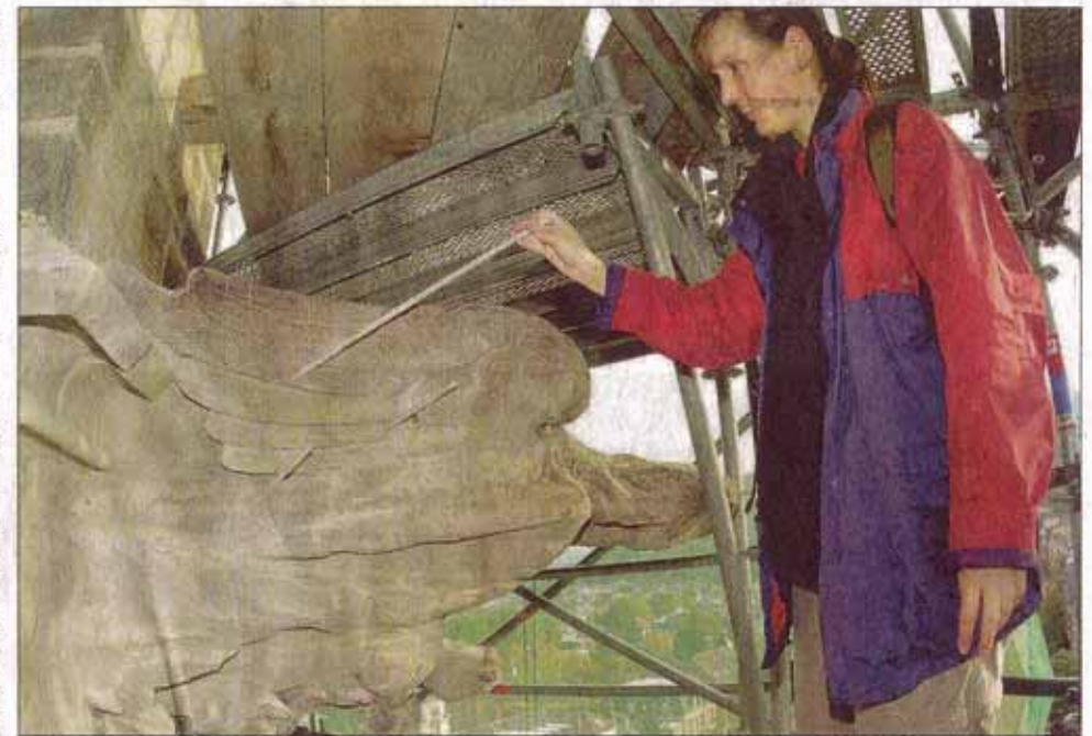
Die Architektin Sonja Behrens prüft die Sandsteinfiguren an der Christuskirche auf ihre Festigkeit. Foto: Stefan Kresin
